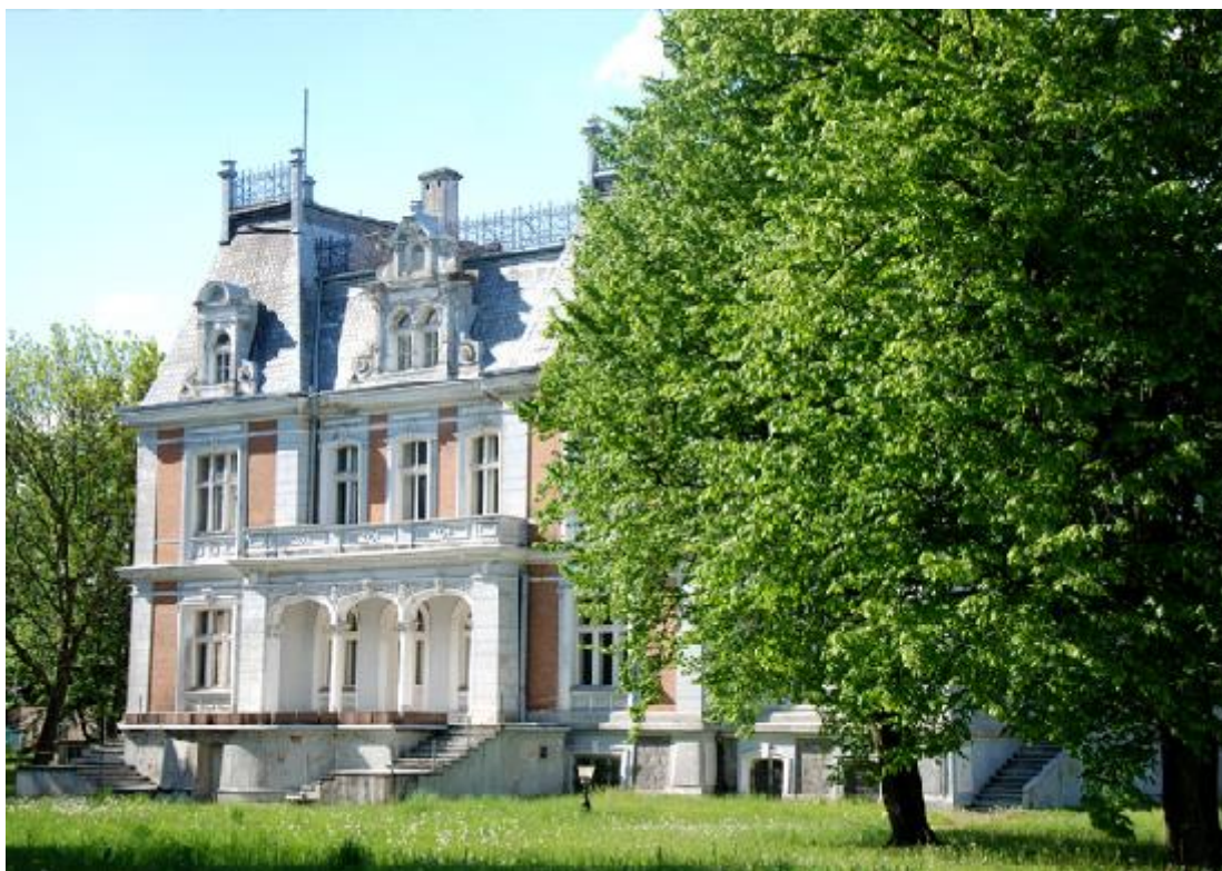
Rysunek 17. Pałac Kindlerów Widzewie (Gmina Ksawerów)
