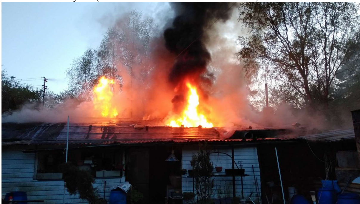
27.04 Wrząca, ul. Piłsudskiego, pożar budynku jednorodzinnego, 1 ofiara śmiertelna, straty materialne ok. 50 tys. zł (fot. OSP Lutomiersk i KP PSP Pabianice)
